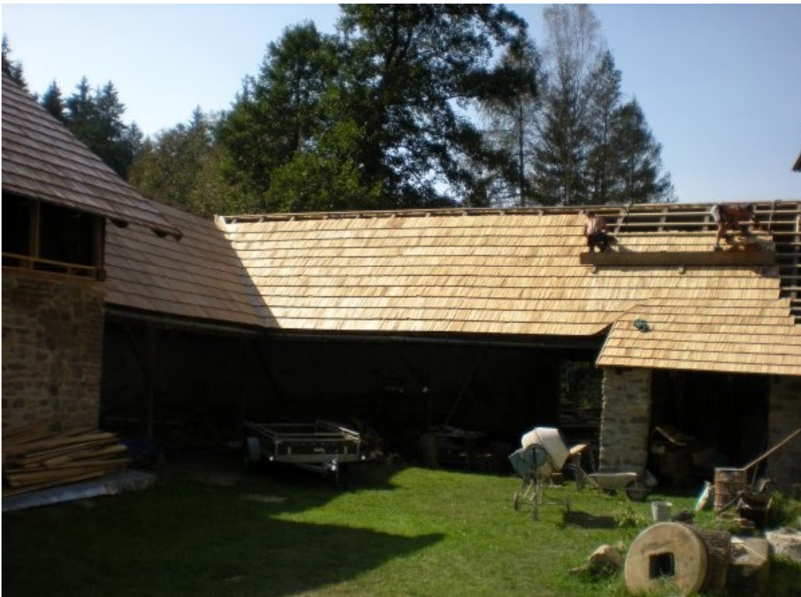
Mlýny Hamry nad Sázavou - realizace šindelové krytiny
