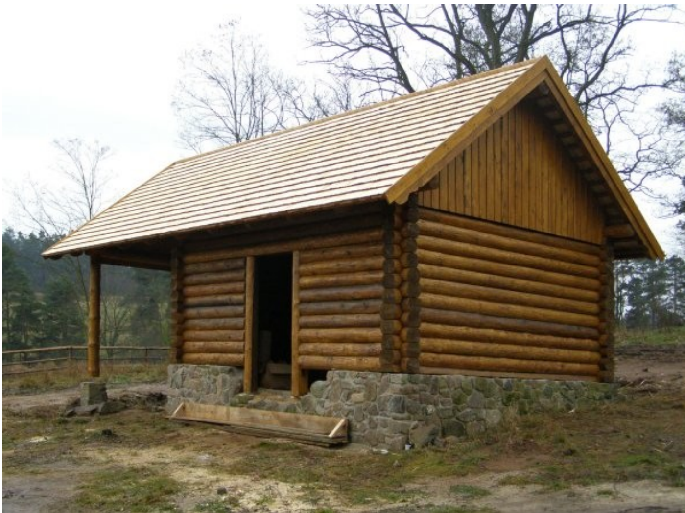
Šindelová krytina na roubené stavbě - Vrš Kamýk
