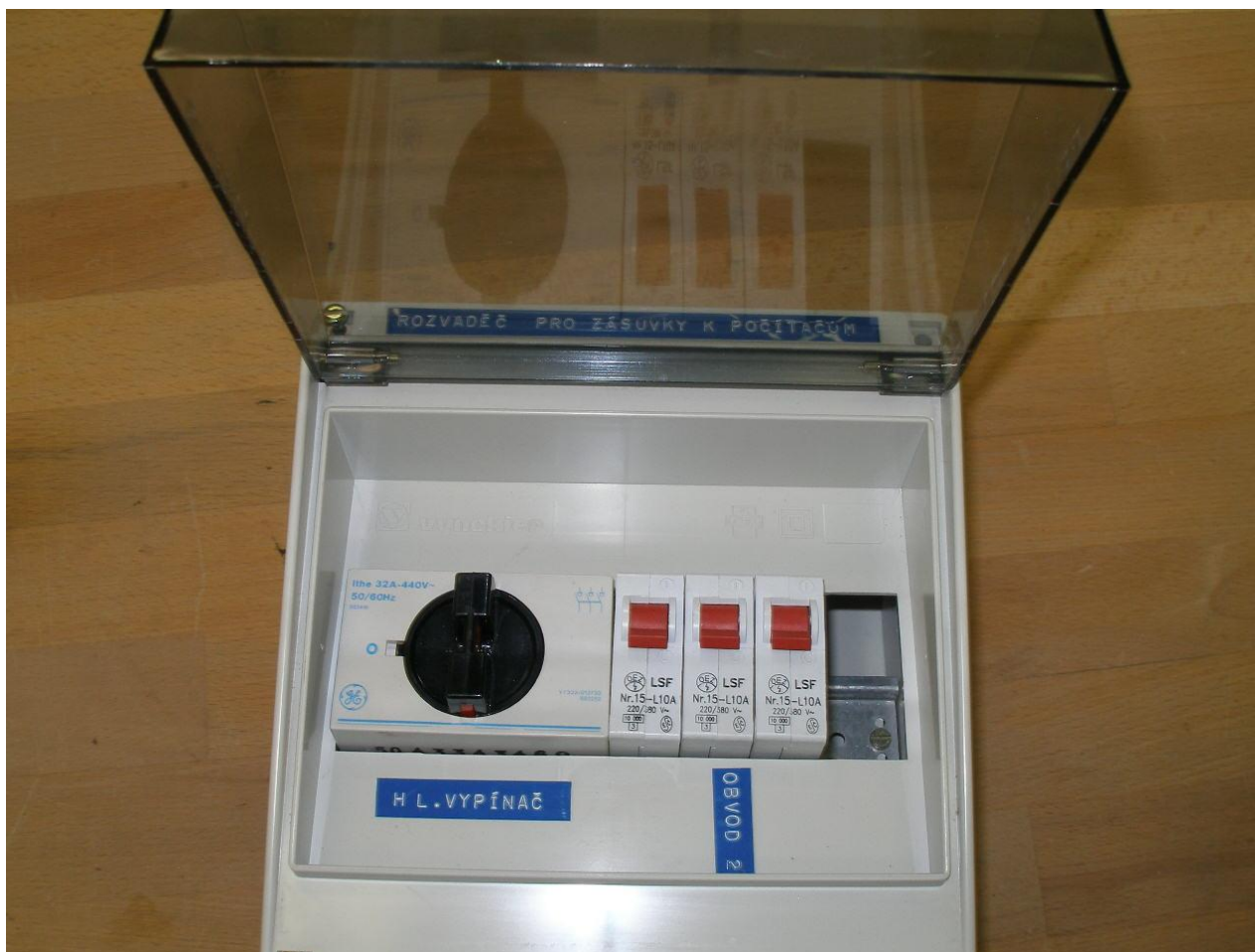
Rozváděč s hlavním vypínačem a jističi
