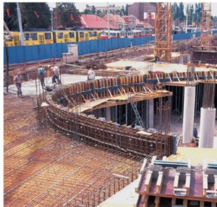
Výztuž sítěmi na staveništi
