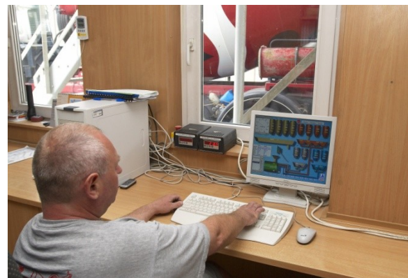
Výroba betonu – řídicí centrum
